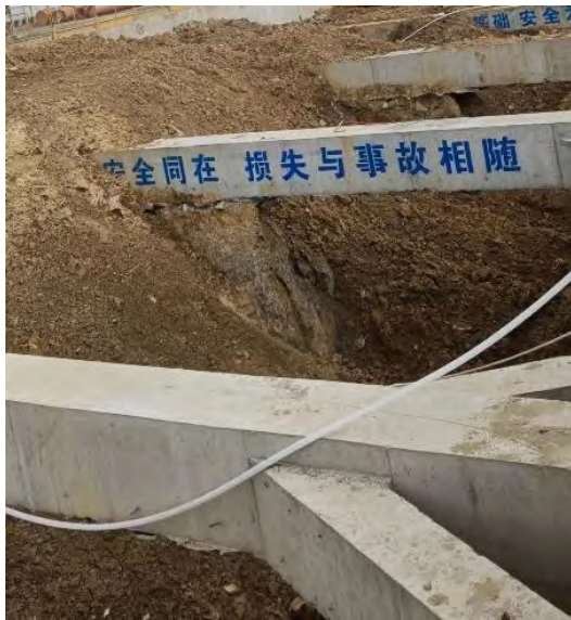
图 4 开挖 6m 时现场工况
