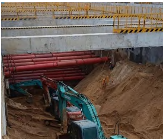
图 9 现场土方开挖施工图
