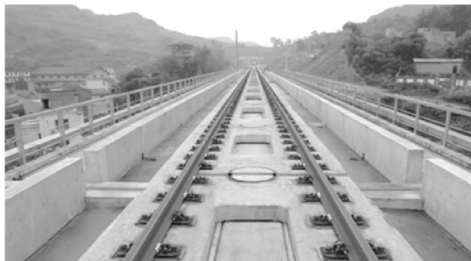
图 5 I 型框架板式无砟轨道
