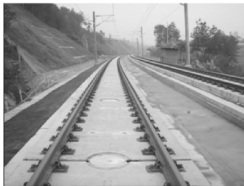
图 4 I 型平板式无砟轨道
