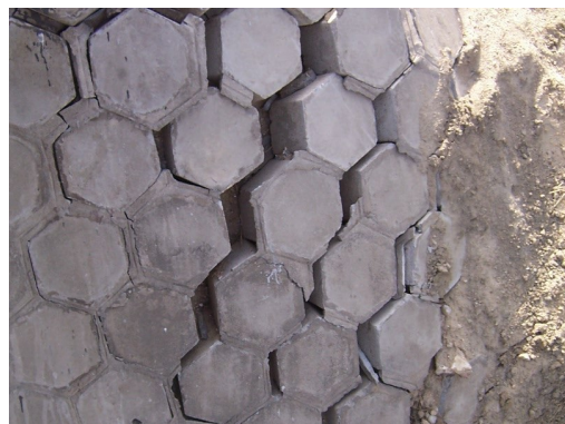
图1 冯官圩桥路基相对桥台的沉降与锥坡开裂
