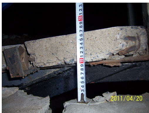
图1 冯官圩桥路基相对桥台的沉降与锥坡开裂
