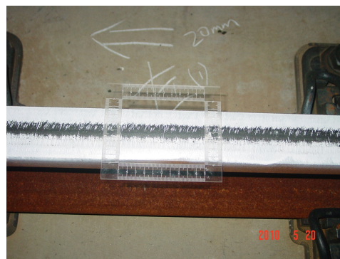
图2 钢轨打磨后光带位置
