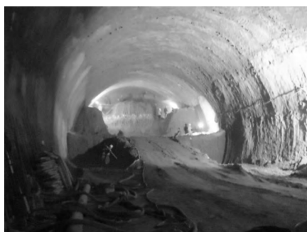
图1 隧道现场施工图
