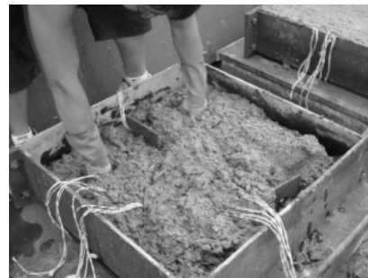
图4 浇筑混凝土图
