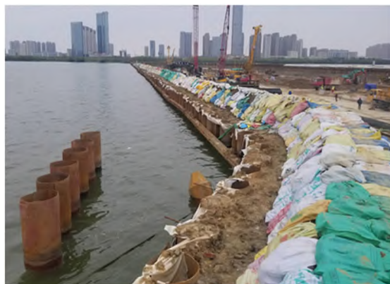
图1 艾溪湖工程:围堰
