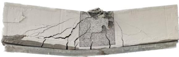
图4 试件JGL-1破坏现象
