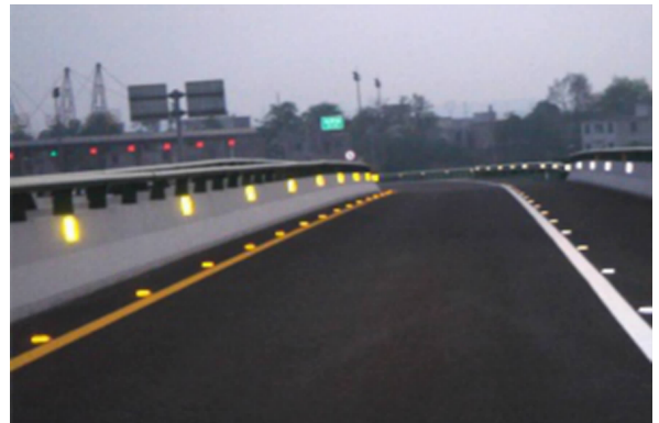
图4 路面突起路标在实际中的应用
