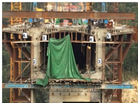
图 5 预应力钢束张拉顺序编号
