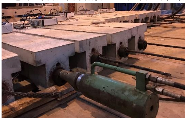
(a) 预应力张拉施工
