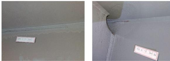
图16 实桥顶板焊根贯穿裂纹
