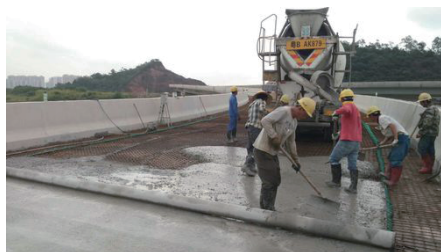
(a) 人工摊铺
