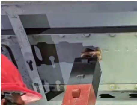
图 21 侧墙感应加热调平照片
