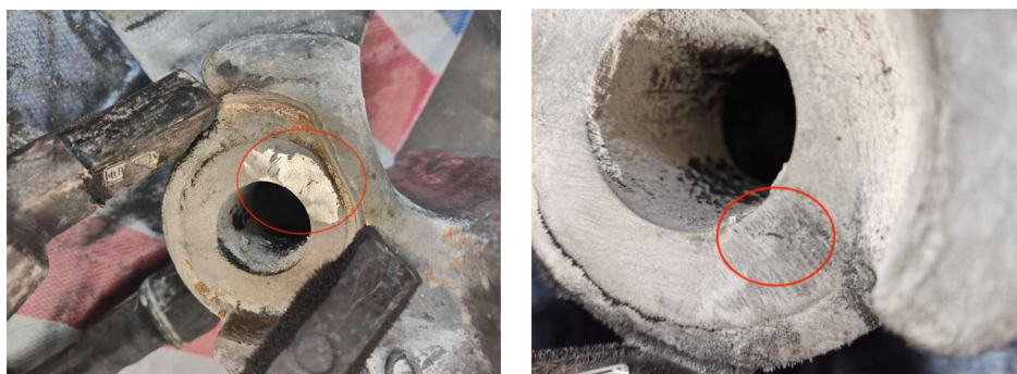
图2 钩舌销孔区域裂纹形貌
