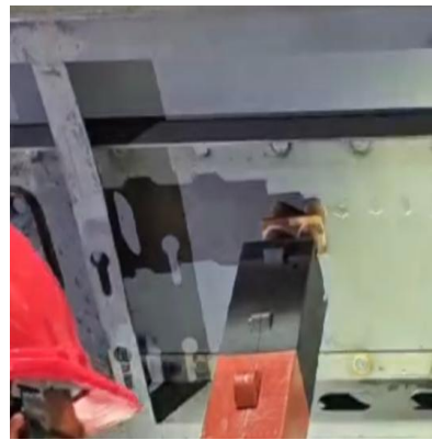
图 26 侧墙感应加热调平照片
