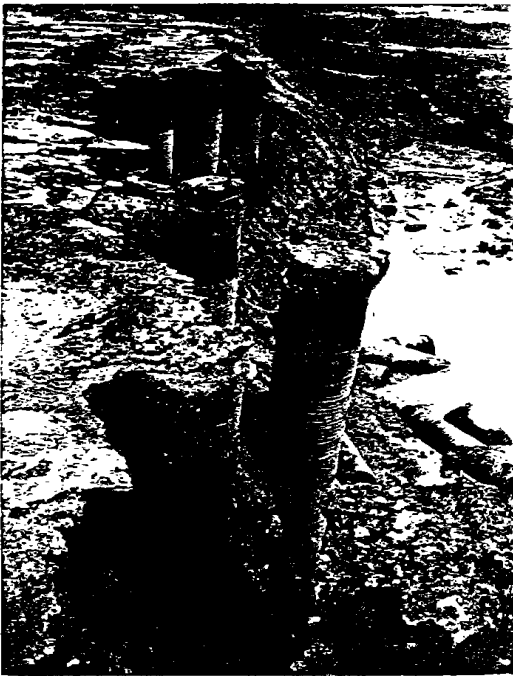
图 2 边坡塌方后的粉喷桩地下图
