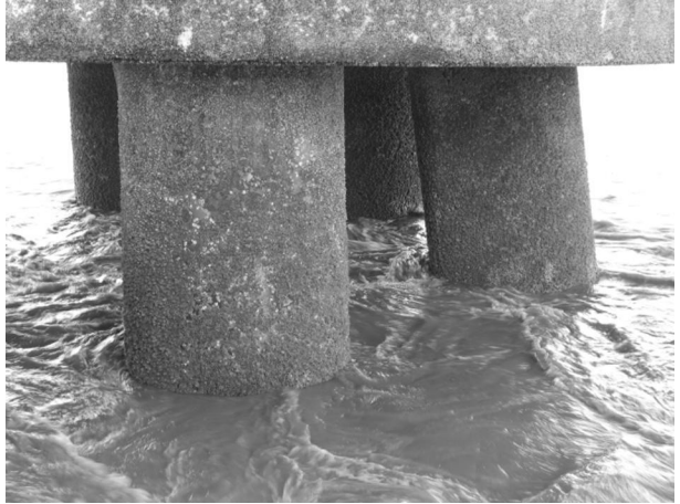
图 1 钢管桩水上可见段防腐效果图
