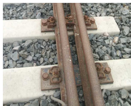
图 3 钢轨扣件源图
