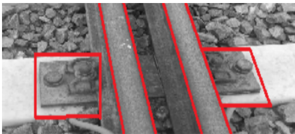
图 5 扣件位置粗定位效果图
