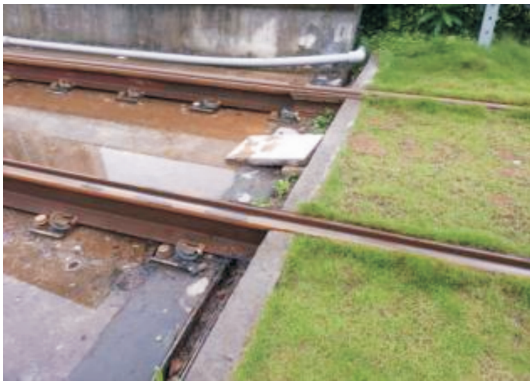
图7 轨道基础刚度过渡段
