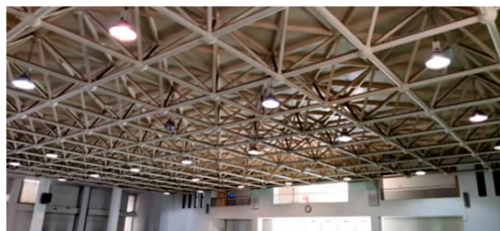
图 4 空间网架的实际结构图
