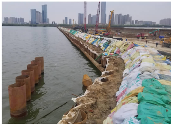
图 1 艾溪湖工程:围堰
