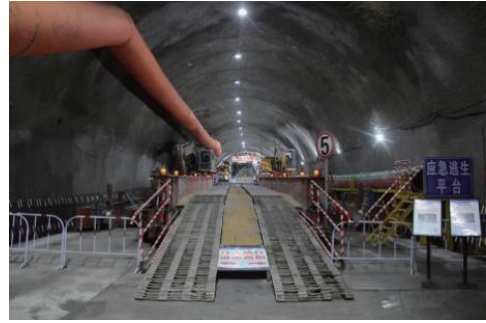
图12 掌子面附近栈桥区段
